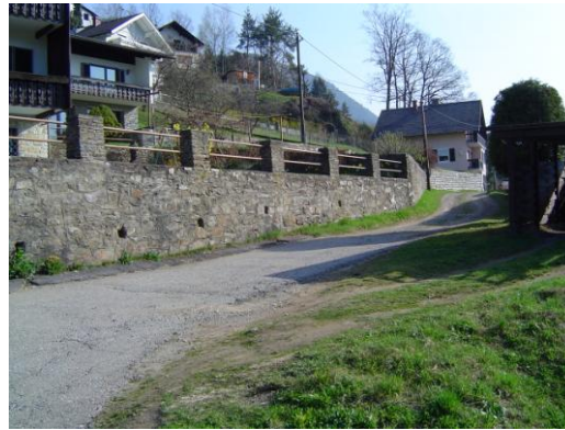
1 e weg rechts; einde van de weg is Haus Brunner
